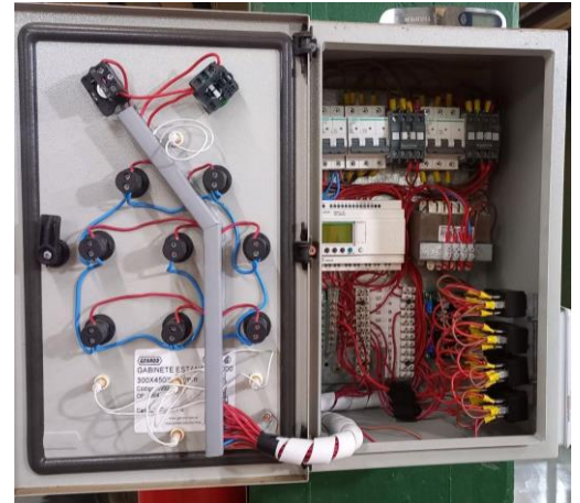
Figura 10. Estado actual del tablero montado
