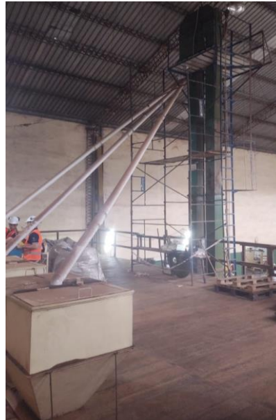
Figura 7. Elevador de cangilones montado y sistema distribuidor
