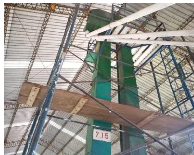
Figura 4. Vista cercana del elevador de cangilones y el cajón distribuidor
