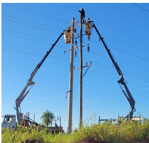
Fig. 9. Instalación de un hilo de guarda en poste de 33 kV, de la línea San Ignacio-Garita [8].
