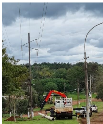
Fig. 10. Fotografía de un poste de hormigón de 33 kV [9].
