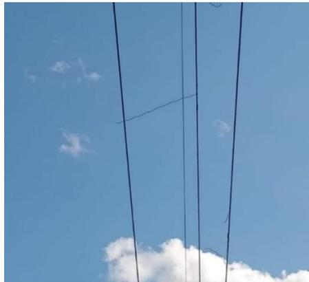
**Fig. 6. Deshilado en red de transmisión 33kV AI-AI.**
