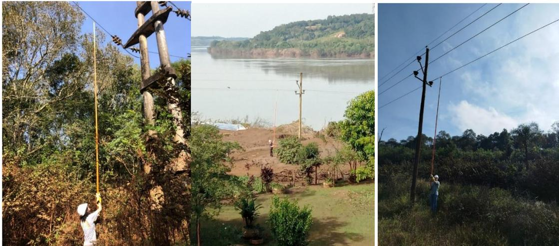
**Fig. 4.** Puntos de mediciones de altura de conductor más bajo en red de transmisión 33kV.
