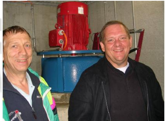
Frente al turbo-generator
