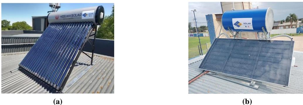
**Fig. 6. Colectores para Utilización Termo Solar [13]. (a) De Tubos de Vacío. (b) De Placa Plana.**
