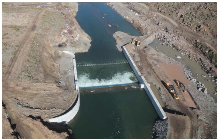
Figura 2. PAH Nahueve (Prov. de Neuquén) actualmente en construcción.
