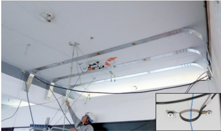
Fig. 7. Reparación de una losa en un edificio escolar en Nieppe, Lille, Francia, mediante láminas de AMF [25].
