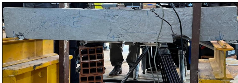
Fig 5. Falla viga Sobre-Armada - V02. Vista posterior.
