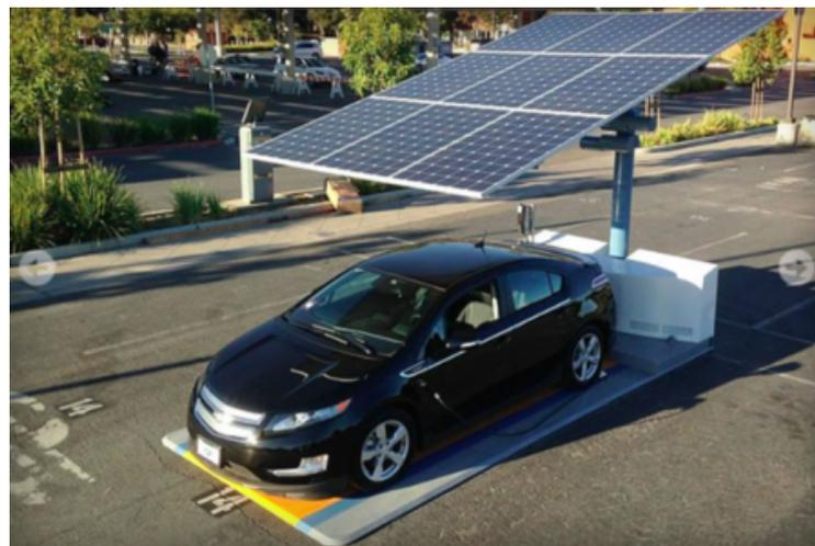
**Fig. 1. Estación solar para recarga**
