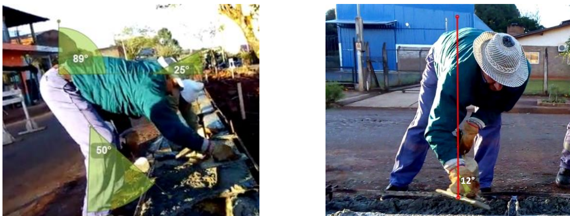
Figura 5- Operario en la posición de análisis y ángulos identificados para aplicar el método REBA. Actividad de alisado y terminación.
