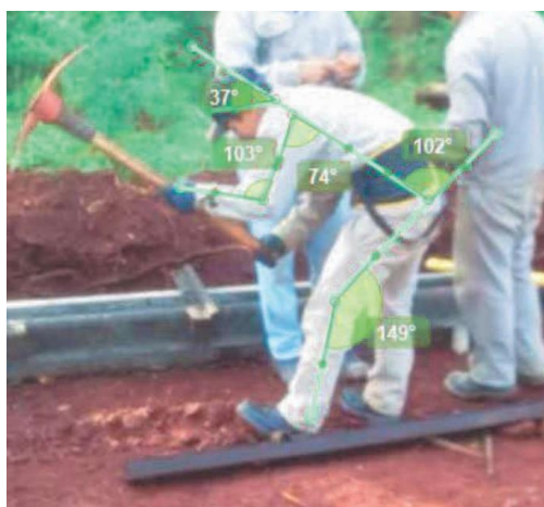
Figura 1- Operario 1 en la posición de análisis y ángulos identificados para aplicar el método REBA. Actividad de colocación de moldes metálicos.
