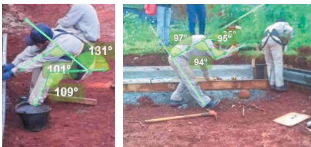
Figura 2- Operarios 2 y 3 en la posición de análisis y ángulos identificados para aplicar el método REBA. Actividad de colocación de moldes metálicos.
