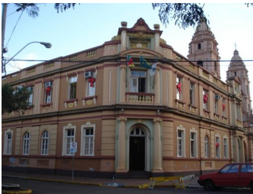
Fig. 1. Edifício da Prefeitura Municipal da cidade de Santo Ângelo (Administração municipal 2012)
