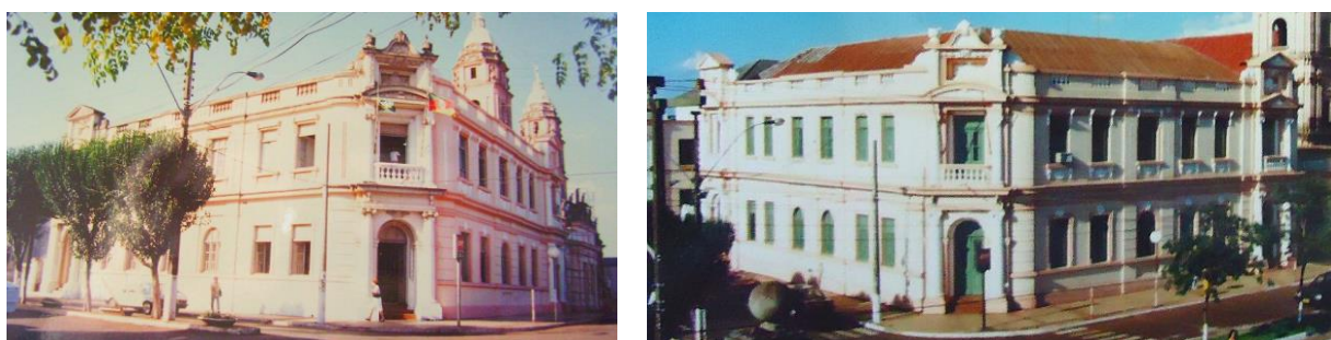
Fig. 7. Fotografia do edifício em 1993 e 2006 respectivamente (Prefeitura Municipal de Santo Ângelo)
