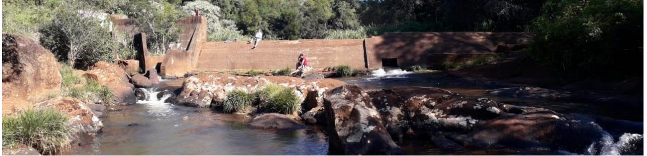
Figura 3: Obra civil, presa existente.
