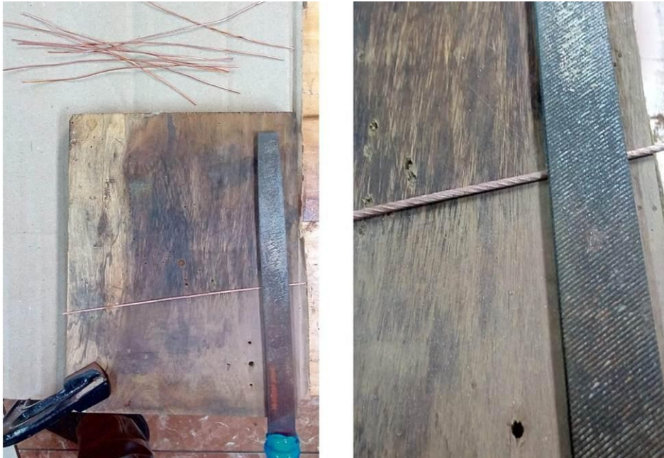
Fig. 3. Proceso de extracción del aislante y marcado de los alambres de cobre
