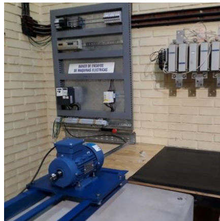
Fig. 2 – Montaje del banco de ensayos
