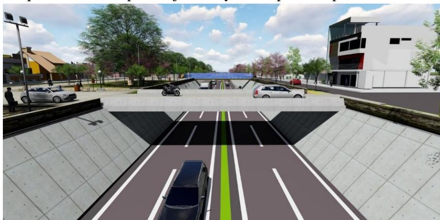
**Fig. 7. Paso bajo nivel y puentes transversales de la Ruta Nacional N°12**
