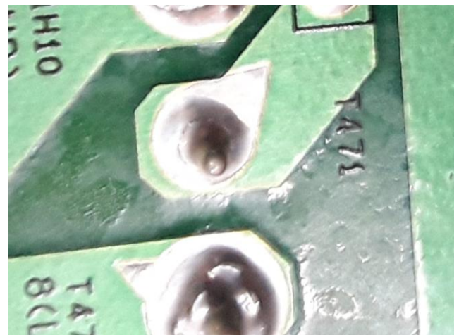
Fig. 7. (b) Falla de soldadura en un inductor
