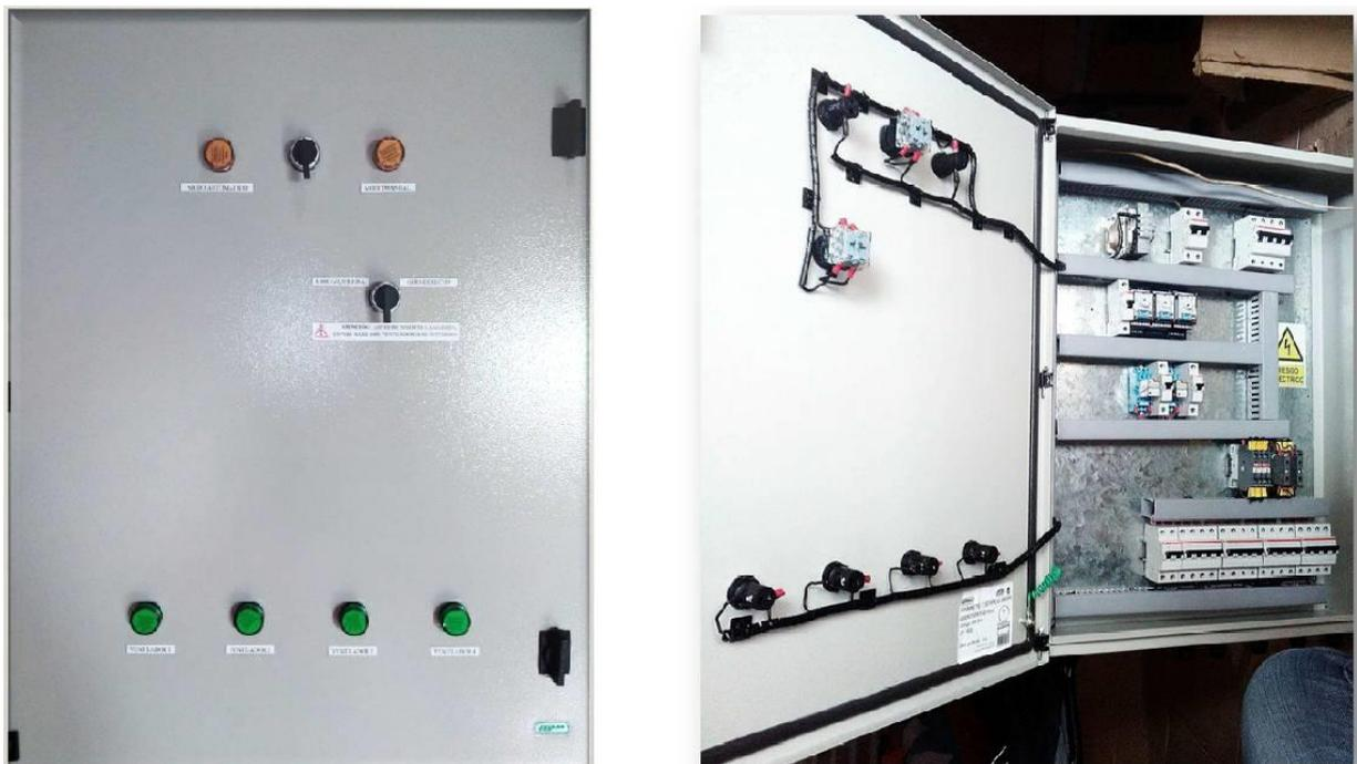
**Fig. 5. Tablero eléctrico terminado (Izquierda: Vista Exterior; Derecha: Vista interior)**
