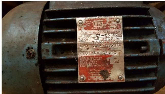
Fig. 2. Placa característica de un motor de la planta
