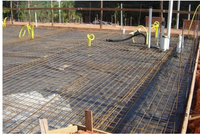
Fig. 1. Fundação superficial em radier .
