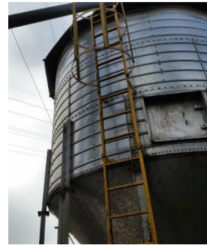
Figura 2: Escalera de acceso al interior del silo y a la parte superior del mismo.
