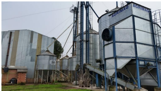
Figura 4: Vista de los silos
