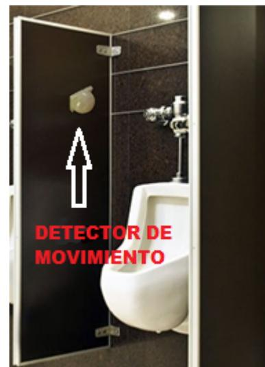
**Figura4:** Ubicación del detector de movimiento.
